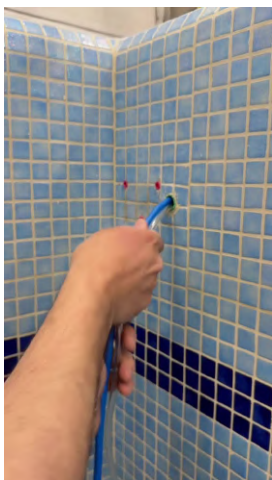
CONDUIT EXIT - 5" ABOVE WATERLINE
